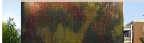
Morspoort parkeergarage L...
